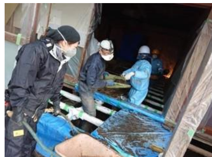
床下の泥の撤去 (宮城県丸森町)
