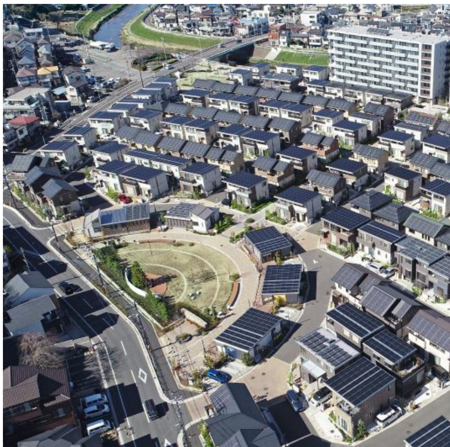
地下に雨水貯留浸透槽、雨水貯留管を整備 （あさかりードタウン（埼玉県朝霞市））
