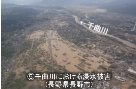
【令和元年東日本台風】
