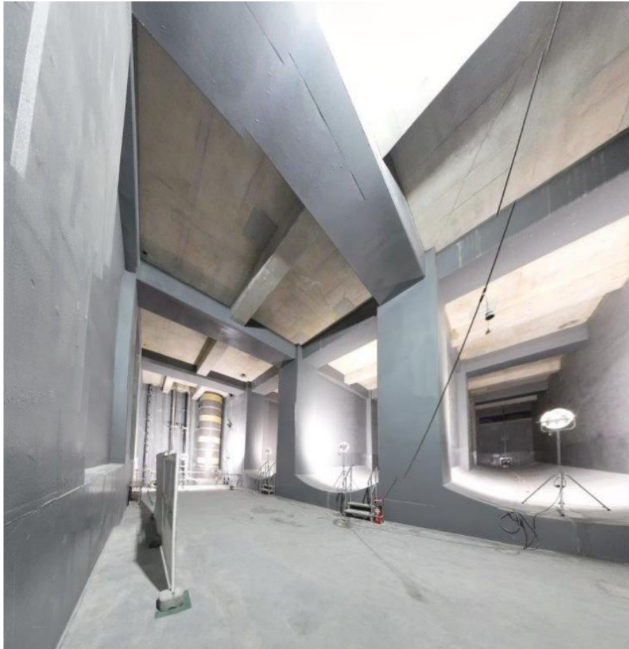
建物の地下に貯留施設を整備 （渋谷駅街区土地区画整理事業（東京都渋谷区））
