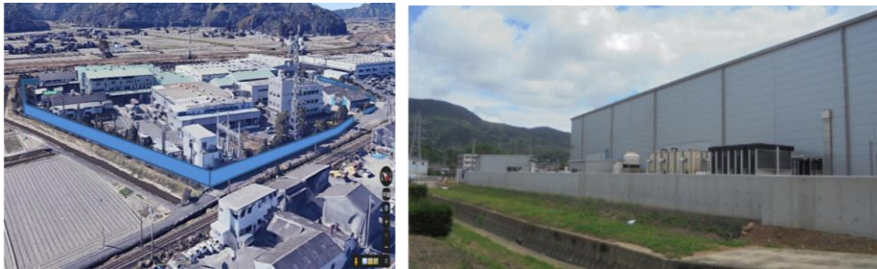
熱処理工場を含む敷地外周の防水壁 (株式会社 佐賀鉄工所 大町工場 (佐賀県大町町))
